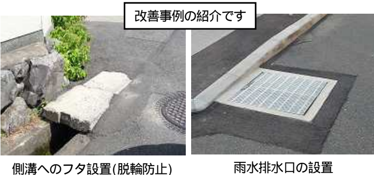
側溝へのフタ設置(脱輪防止)
