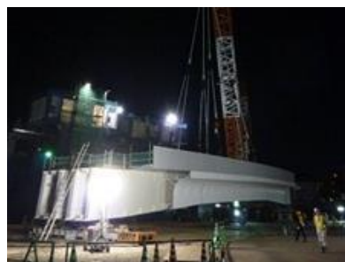
A出入口部高架橋
