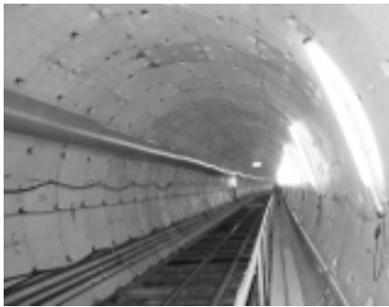
工事中の今里雨水貯留幹線のトンネル内部
