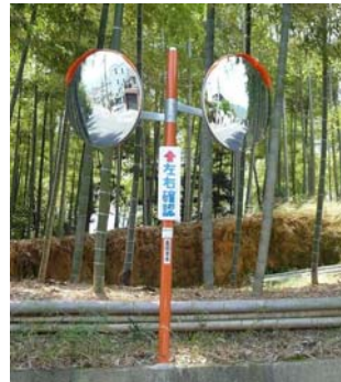
T字交差点へのカーブミラー設置
