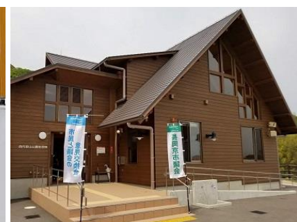
西代里山公園管理棟
