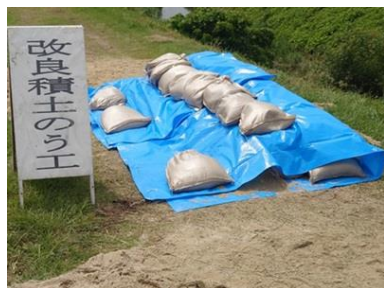
改良積土のう工法
